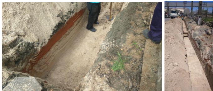
PREPARO DA BASE DE ASSENTAMENTO DOS DUTOS
