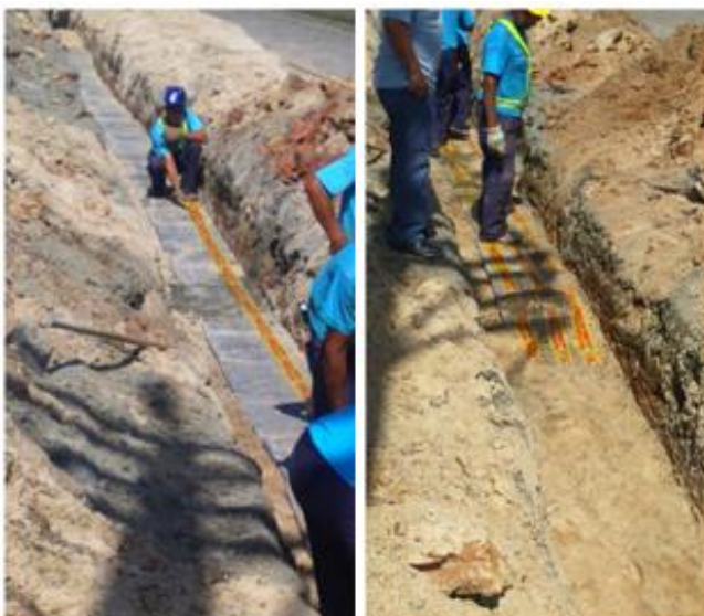
INSTALAÇÃO DA FITA DE AVISO
