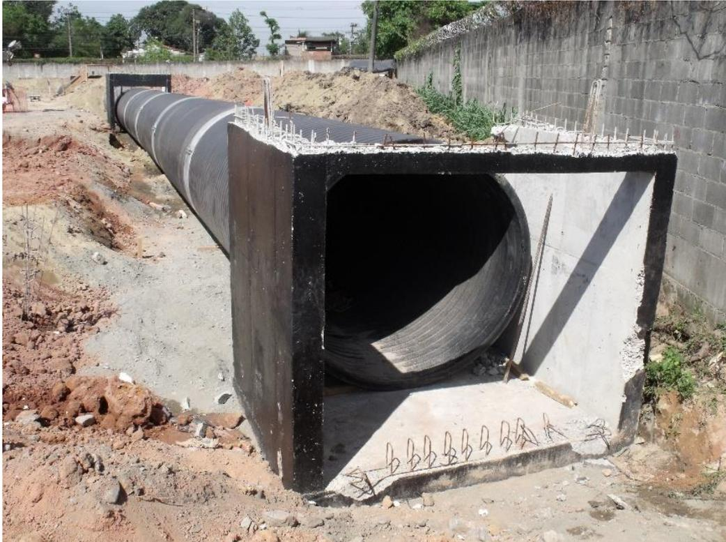
*Figura 28 – Chegada/saída em Caixa de Passagem ou PV*
