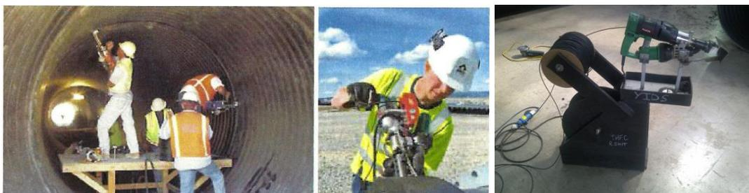
*Figura 29 - Solda por extrusão manual*
