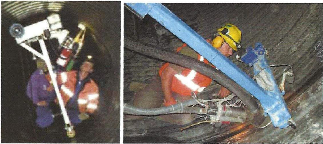
*Figura 30- Solda por máquina de solda interna*
