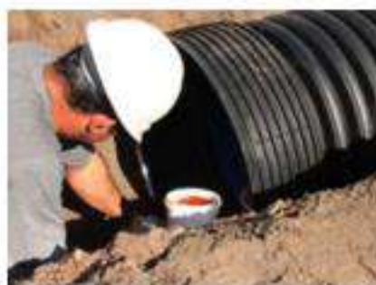
Figura 38 - Aplicação da pasta lubrificante
