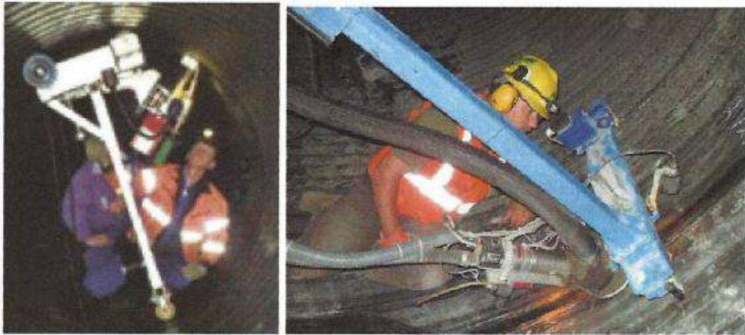
Figura 30- Solda por máquina de solda interna
