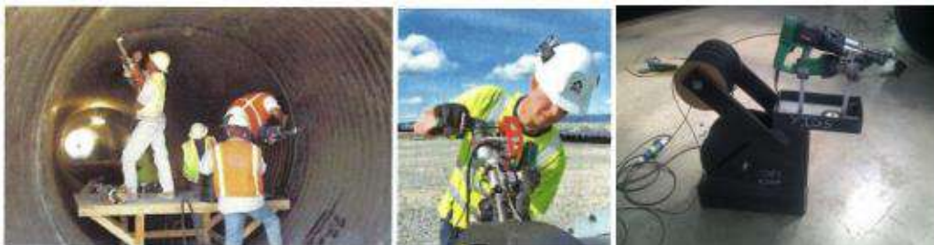
Figura 29 - Solda por extrusão manual
