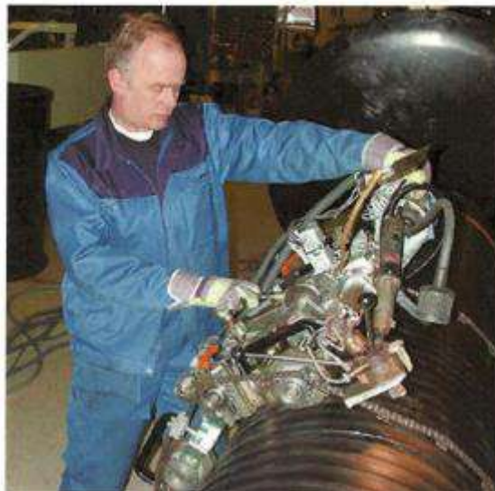
Figura 31 - Solda por máquina de solda externa
