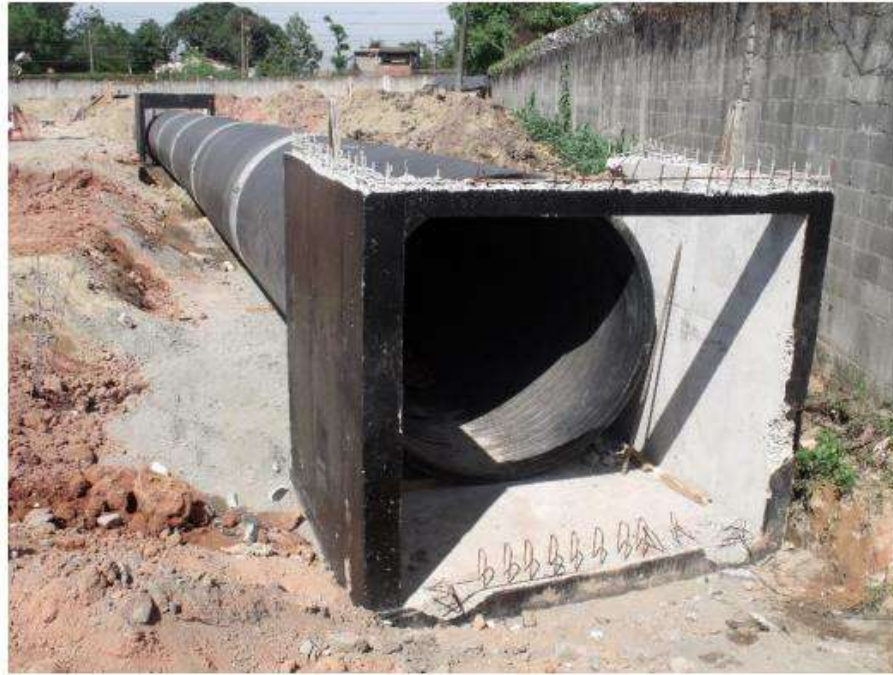
Figura 28 – Chegada/saída em Caixa de Passagem ou PV
