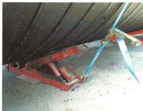
Figura 34 - Prenda os tubos em um suporte tipo V
