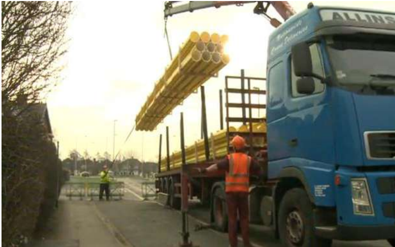
Figura 18 – Descarregamento de tubos lisos em barra, com caminhão munck e um homem-guia.
