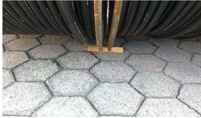
Figura 19 – Travamento dos carretéis com toco de madeira.
