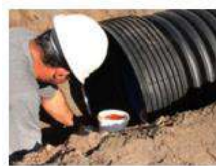
Figura 38 - Aplicación de la pasta lubricante
