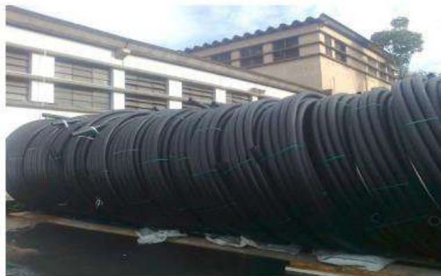
Figura 15 – Almacenamiento de tuberías en posición vertical (para DE 63 a 110 mm).
