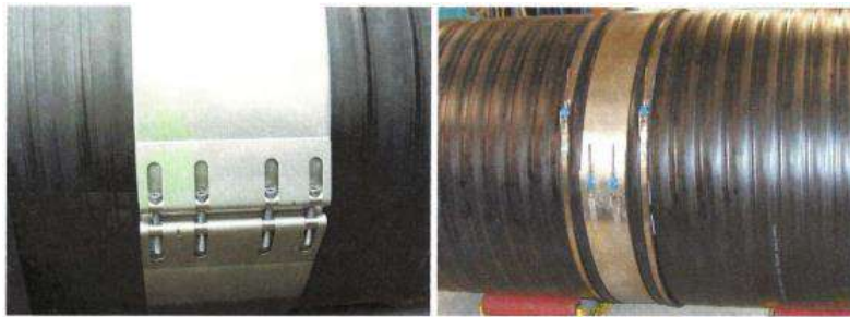
Figura 35 - Cubrir las holguras con la cincha metálica Figure 35 - Cover the gaps with the metallic band
