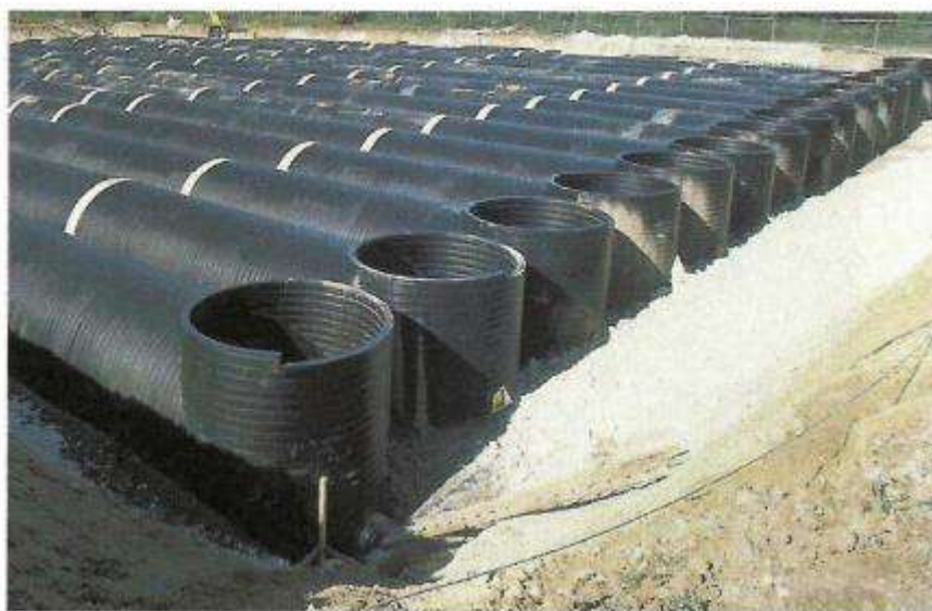
Figura 45 - Tanque de retención o detención construido con tubos KANAWEHOLITE
