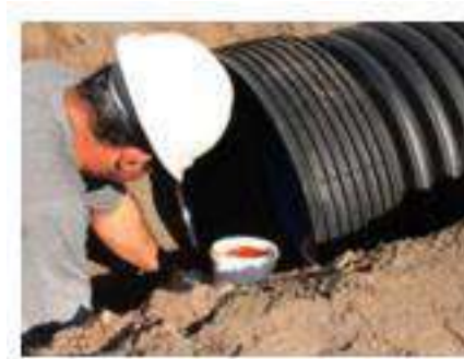
Figura 38 - Aplicación de la pasta lubricante
