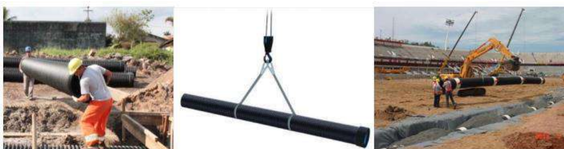
Figura 45 - Descarga y manipulación manual y con fajas de nylon
